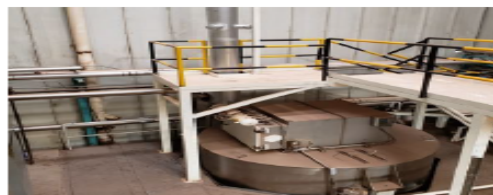
Fotografía 12. Silos de Nibs Tostados
